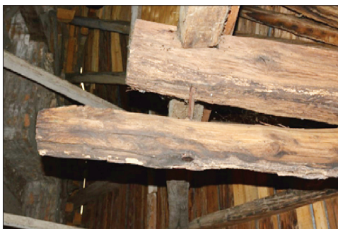
Foto 3. Degradări fizico-chimice și biologice ale lemnului, șarpantă, verticală clește deasupra cafas.
