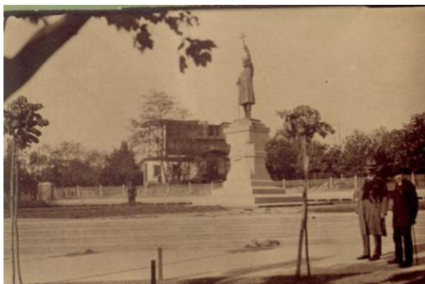
Vedere din perioada interbelică, Grădina Publică, monumentul lui Ștefan cel mare, împrejurirea de fontă și porțile Grădinii Publice, realizate după schița arhitectului orașului Chișinău Alexandr Bernardazzi
