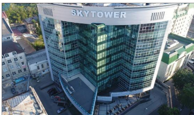
Figura 4. Clădirea Centrului Internațional de Business „SKYTOWER” (high-tech).
