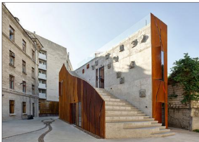
Figura 9. Clădirea Centrului industriilor Creative ARTCOR (brutalism).
