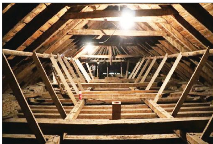
Foto 2. Șarpantă, biserica din Ceplenița.
